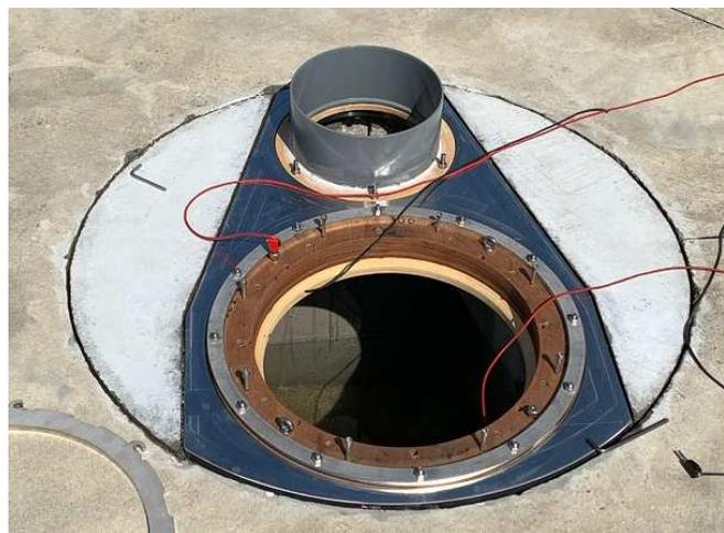
Figure 4 Installation de l'outillage d'interface pour HP de 46cm, ainsi que de la rondelle d'accueil des tronçons d'évent
