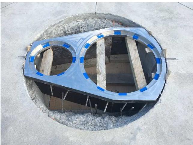
Figure 3 Une plaque en inox de 44 mm usinée dans la masse a été scellée dans la dalle afin de recevoir les outillages d'interface
